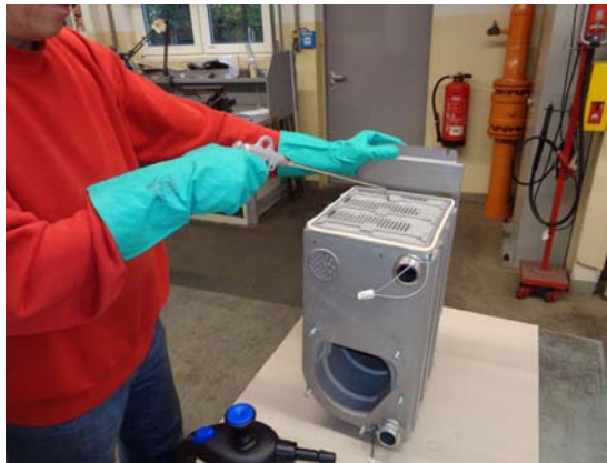
Abb. 18: Wartungsarbeiten (mit erweiterter Reinigung) am Gas-Brennwertgerät, Schritt 6
